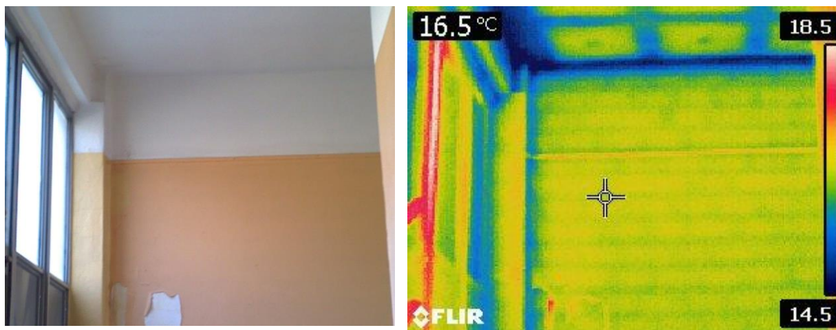
Figura 4.5 – Rilievo termografico della parete
